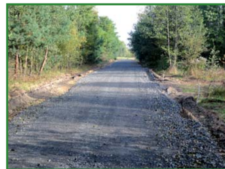
Budowa drogi Franciszków–Młodocin Większy
