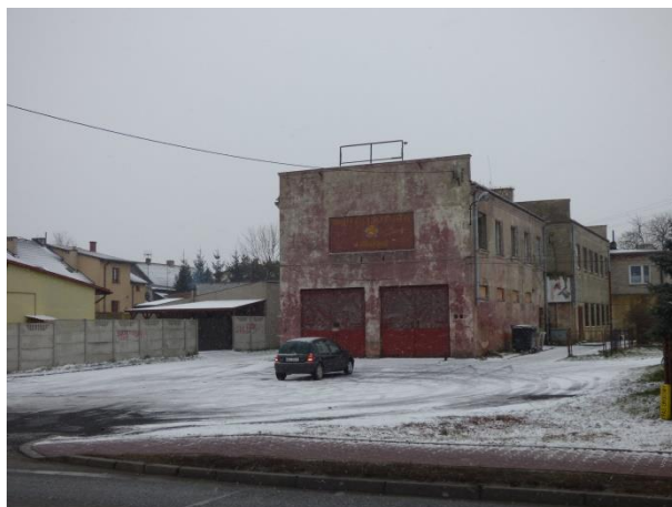
Fot. 2. Budynek Strażnicy w Wolanowie
