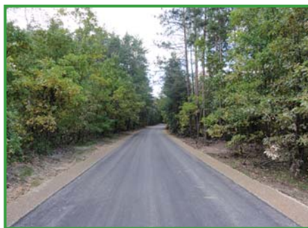
Przebudowa drogi Zabłocie-Bieniędżice
