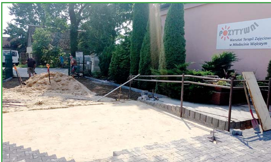
Układanie nawierzchni z kostki betonowej przed budynkiem WTZ w Młodocinie Większym
