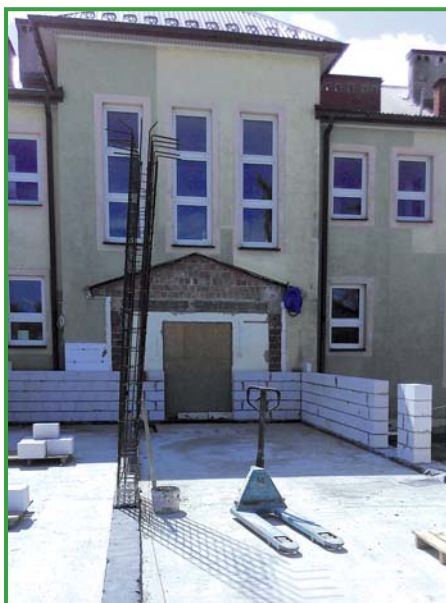
Prace przy rozbudowie szkoły w Sławnie
