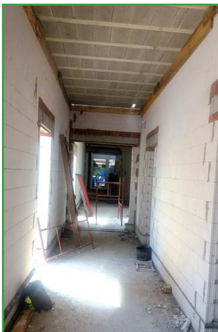
Prace przy rozbudowie szkoły w Mniszku
