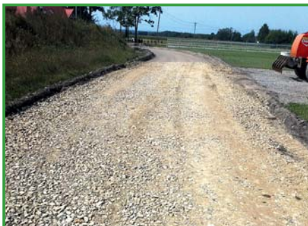
Profilowanie konstrukcji drogi
