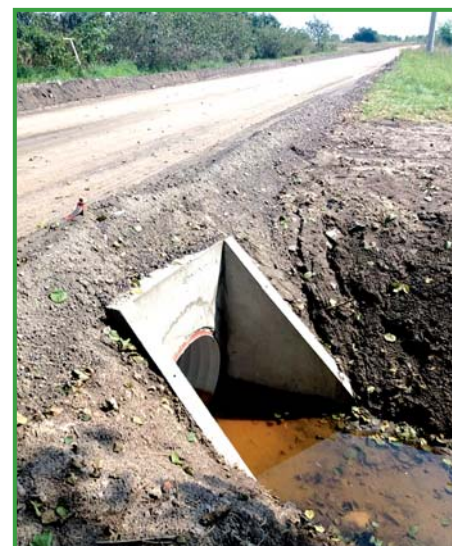
Wymiana przepustu przy przebudowie drogi
