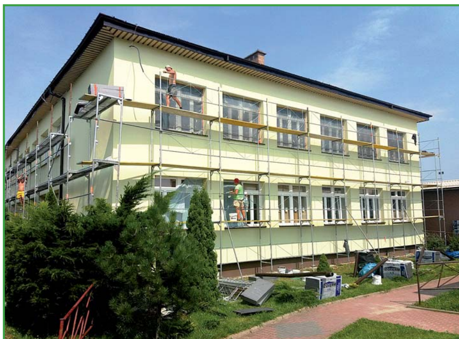
Termomodernizacja budynku PSP w Wolanowie
