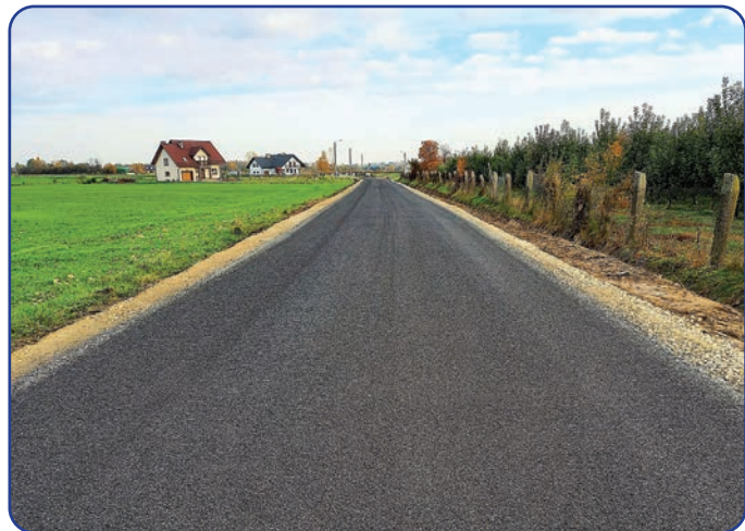
Droga w miejscowości Strzałków przed i po utwardzeniu destruktem
