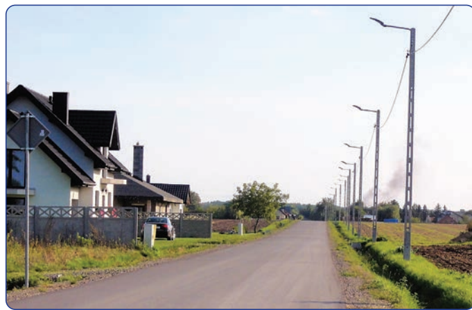
Przebudowa drogi Sławno – granica z gminą Zakrzew wraz z oświetleniem
