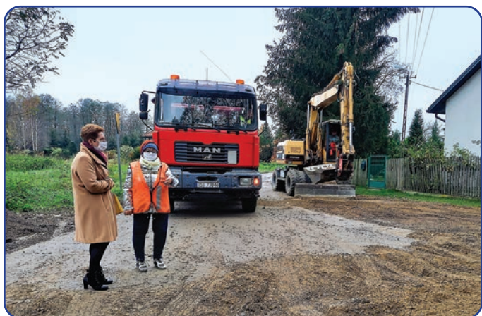
Droga Zabłocie – Bieńdżice przed, po i w trakcie realizacji
