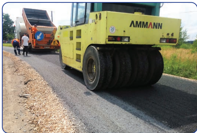
W trakcie prac remontowych
