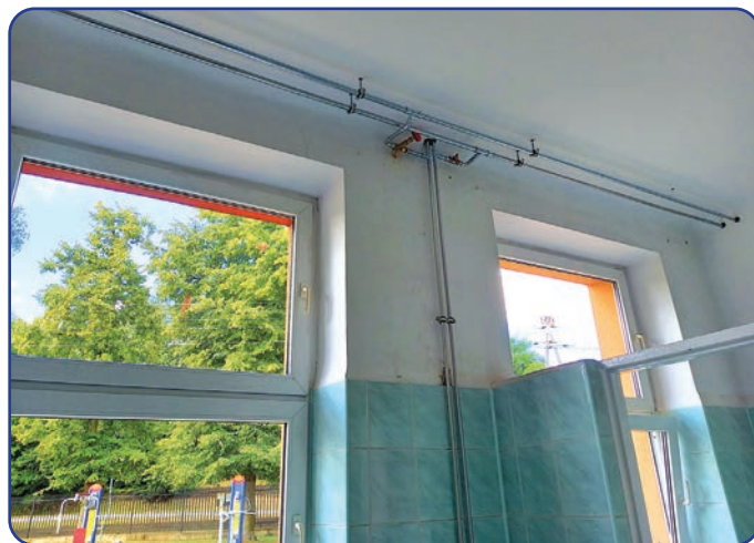
Odświeżone pomieszczenia PSP w Bieniędzicach z nową instalacją gazową
