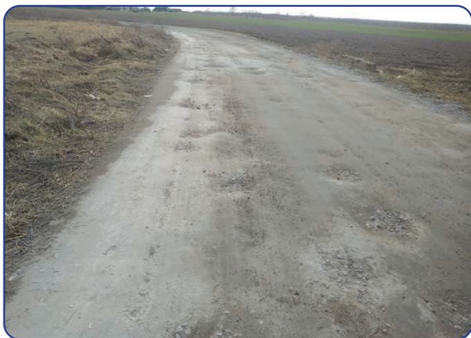
Droga relacji Michałów – Kolonia Wawrzyszów przed i po utwardzeniu destruktem
