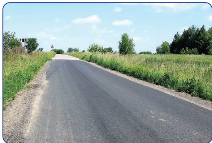
Droga relacji Sławno – Podlesie przed i po utwardzeniu destruktem
