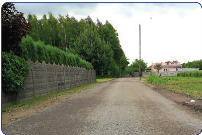
Droga na granicy sołectw Mniszek i Wawrzyszów – utwardzenie destruktem
