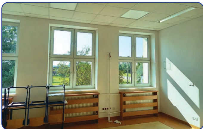
Jedna z sal lekcyjnych po wymianie instalacji w starej części PSP w Sławnie
