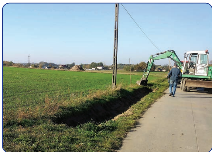
W trakcie prowadzonych robót ziemnych – Kowala Duszocina
