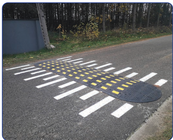
Pierwsze progi zwalniające – zamontowane w miejscowościach Strzałków i Mniszek
