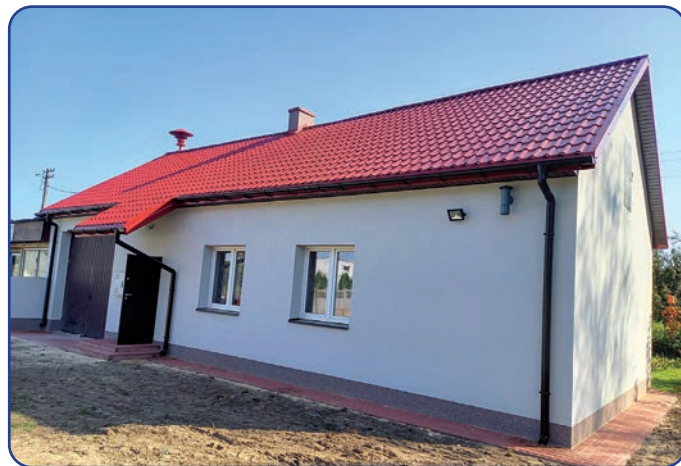
Termomodernizacja remizy OSP/świetlicy w Jarosławicach – elewacja frontowa
