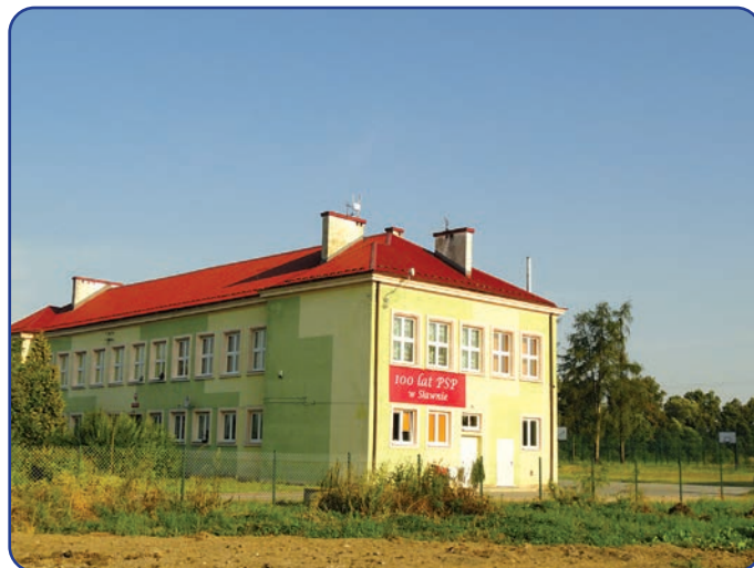
Widok elewacji starej części PSP w Sławnie przed termomodernizacją
