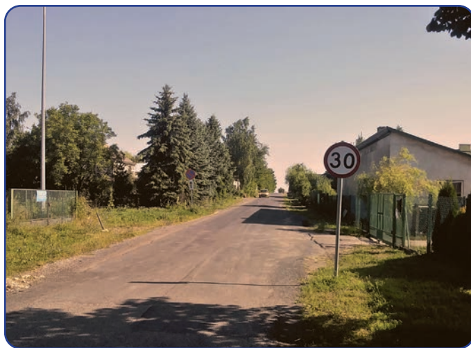
Ta sama droga przed przebudową
