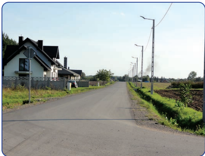
Zakończona realizacja przebudowy I etapu drogi Sławno – granica z gminą Zakrzew
