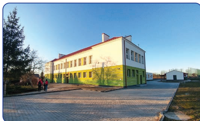
Widok elewacji starej części PSP w Sławnie po termomodernizacji
