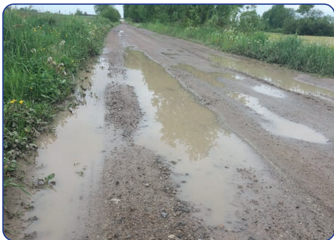
Droga w Chruślicach przed przebudową
