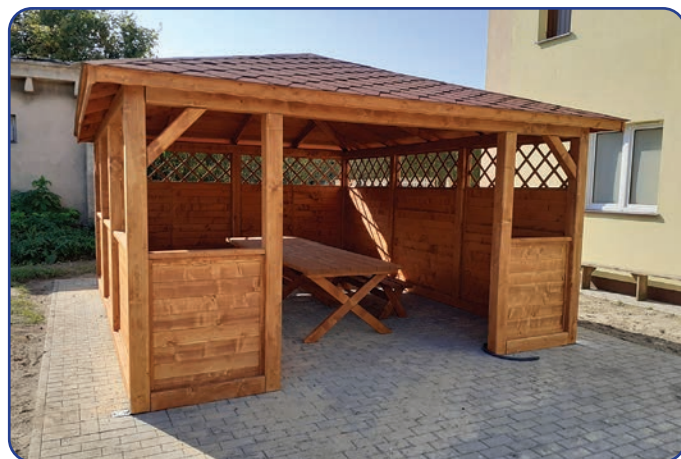
Utworzenie miejsca rekreacji w sołectwie Chruslice – altana i utwardzenie placu przy Klubie Senior+
