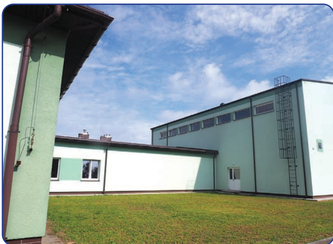
Sala gimnastyczna w PSP w Mniszku z zewnątrz
