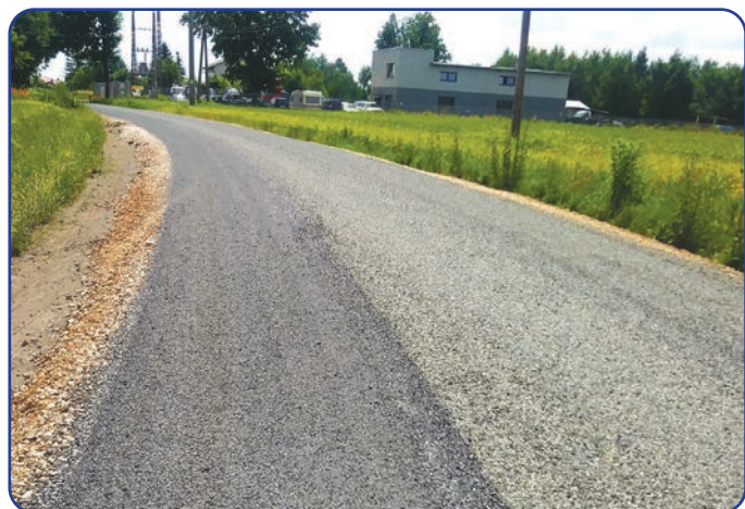
Droga w Ślepowronie przed i po utwardzeniu destruktem
